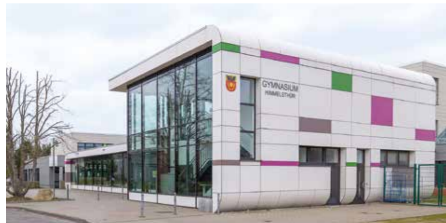
Die 2010 gebaute Mensa prägt das Gesicht des Gymnasiums Himmelsthür – ansonsten ein funktionaler Bau der 1960er Jahre
